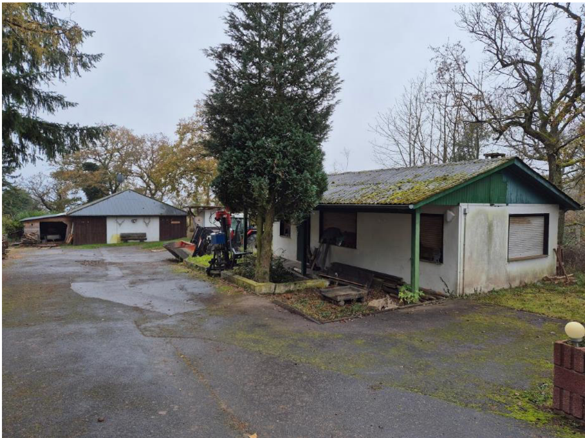
Abbildung 4: Blick auf die beiden vom Eingriff betroffenen südlichen Gebäude in Eingriffsfläche 1
