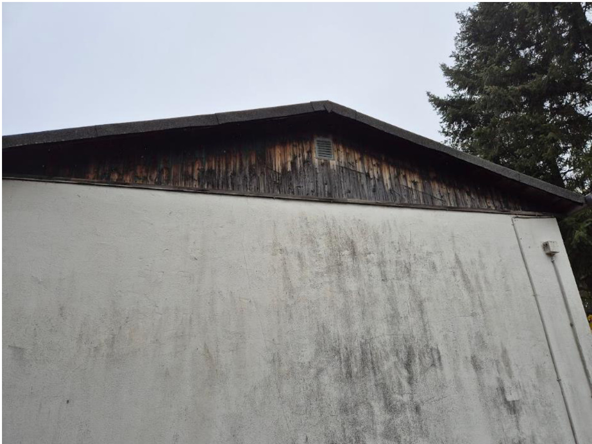
Abbildung 14: Blick auf die Fassade und den Giebel des nördlichen Gebäudes
