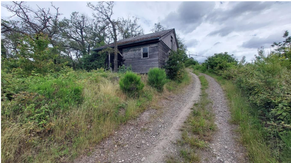
Abbildung 11: Blick auf den vom Eingriff betroffenen Schuppen in Eingriffsfläche 2
