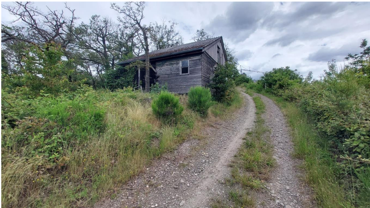
Abbildung 23: Blick auf den vom Eingriff betroffenen Schuppen in Eingriffsfläche 2
