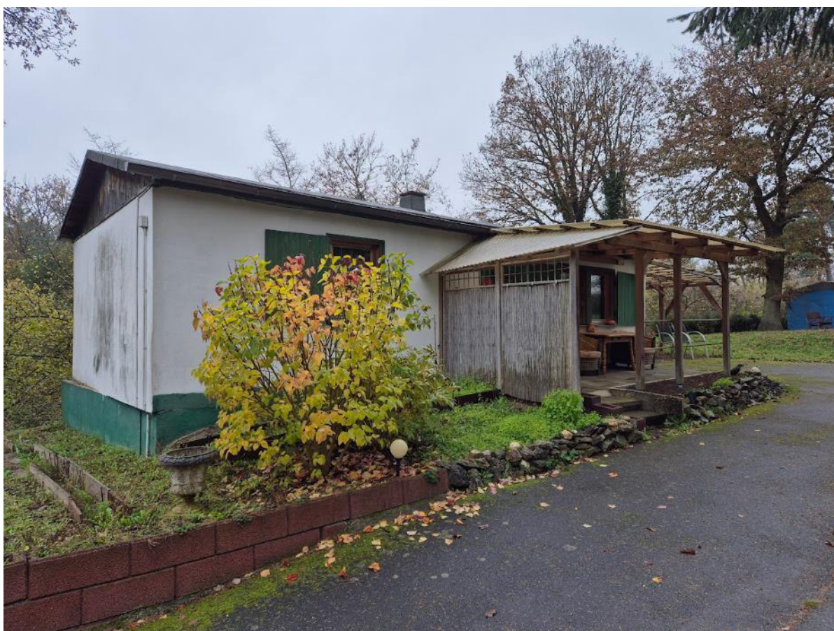
Abbildung 5: Blick auf das vom Eingriff betroffene nördliche Gebäude in Eingriffsfläche 1
