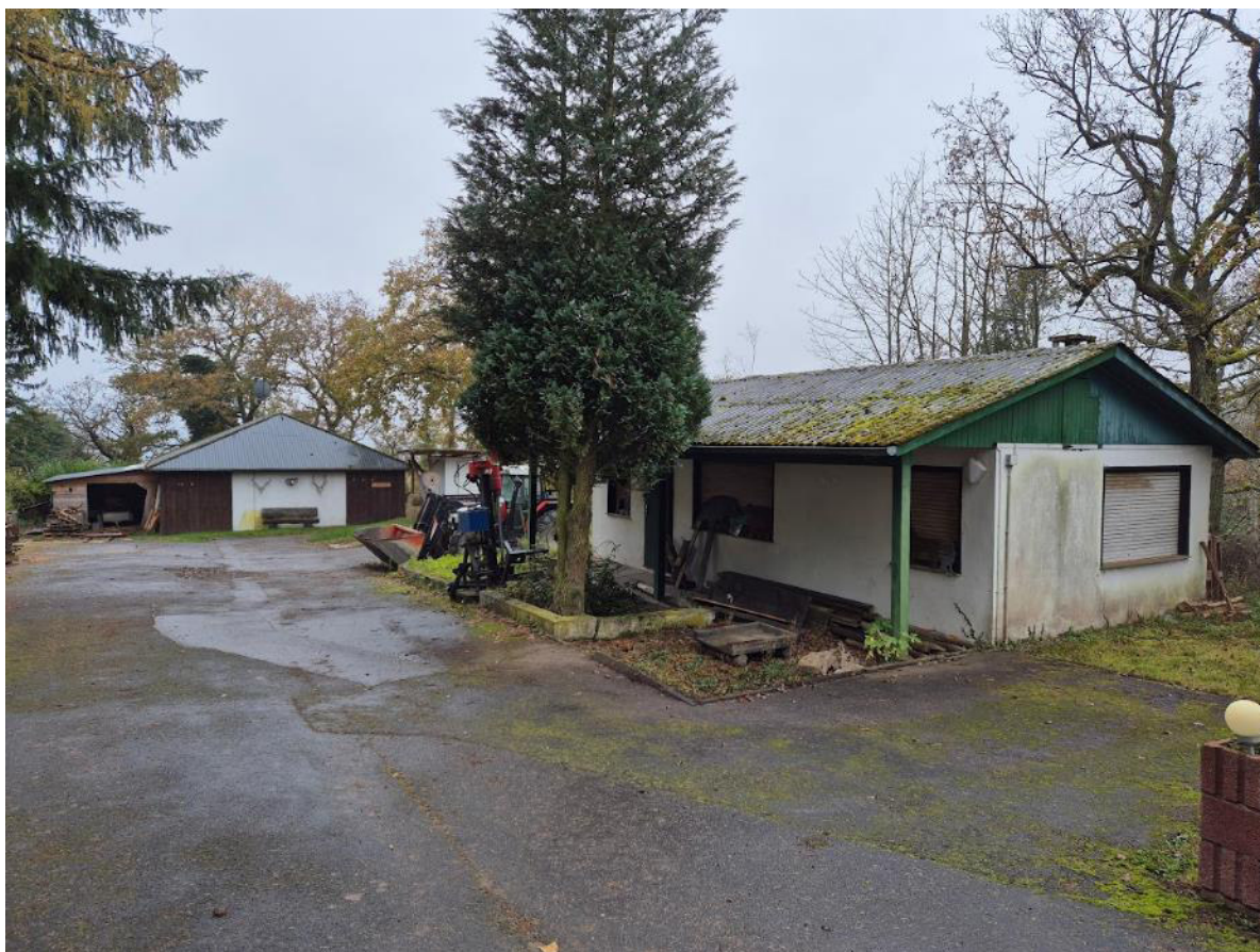
Abbildung 16: Blick auf die beiden vom Eingriff betroffenen südlichen Gebäude in Eingriffsfläche 1
