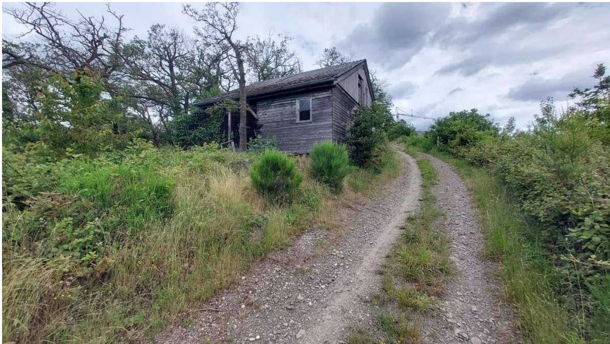
Abbildung 11: Blick auf den vom Eingriff betroffenen Schuppen in Eingriffsfläche 2
