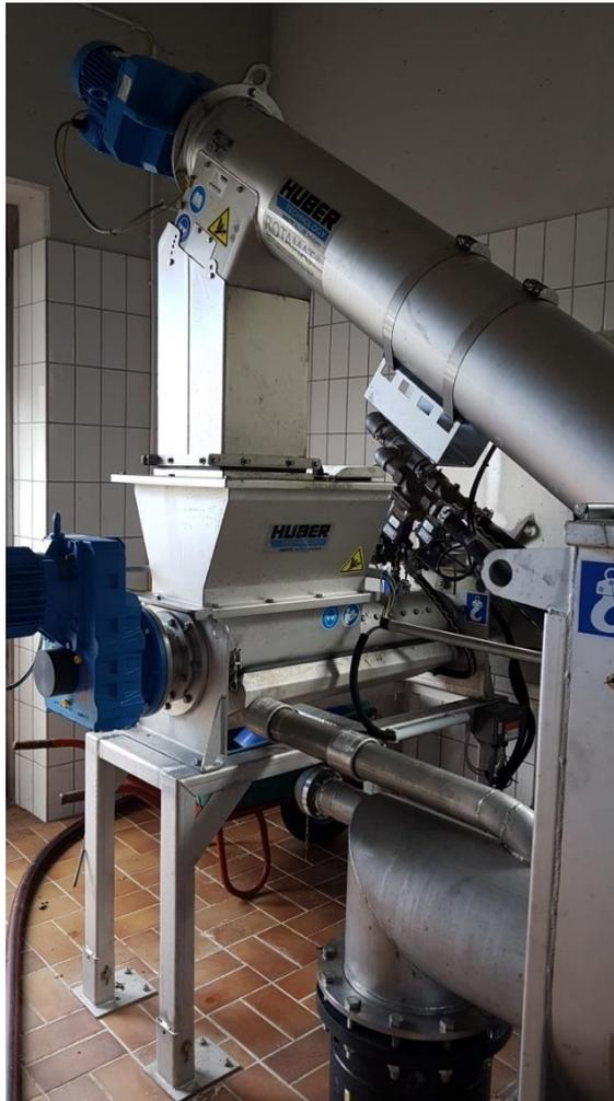
Abb. 3: Kompaktrechenanlage und Rechengutwaschpresse
