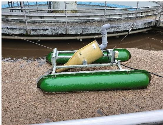
Abb. 6: Oberflächenbelüfter Belegung
